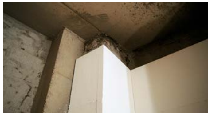
Detail C - Montierte PROMATECT®-MC-Platten
