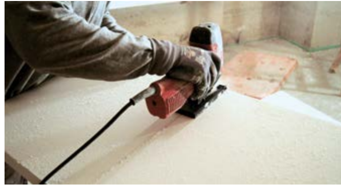
Detail A - Einfaches Zuschneiden von PROMATECT®-MC-Platten
