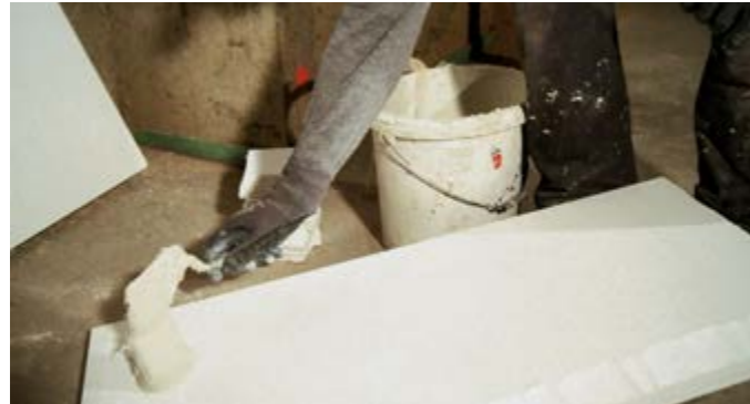
Detail B - Auftragen von PROMATECT®-MC-Klebespachtel
